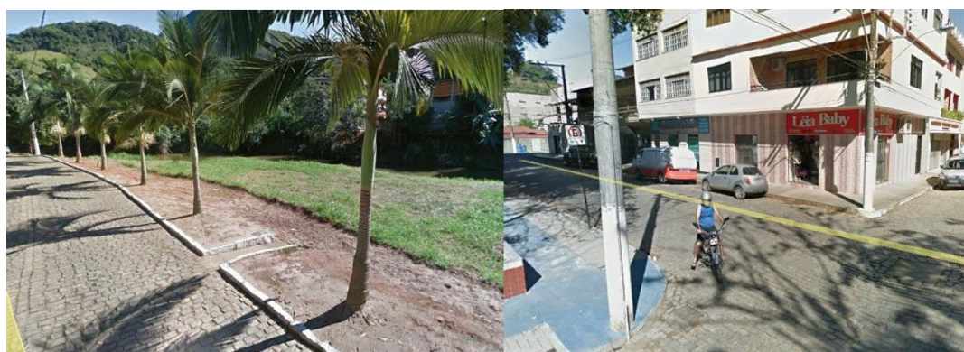
Figura 54 – Aspectos da microdrenagem implantada no município
