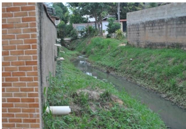
Figura 58 – Situação localizada - descartes do sistema de microdrenagem
